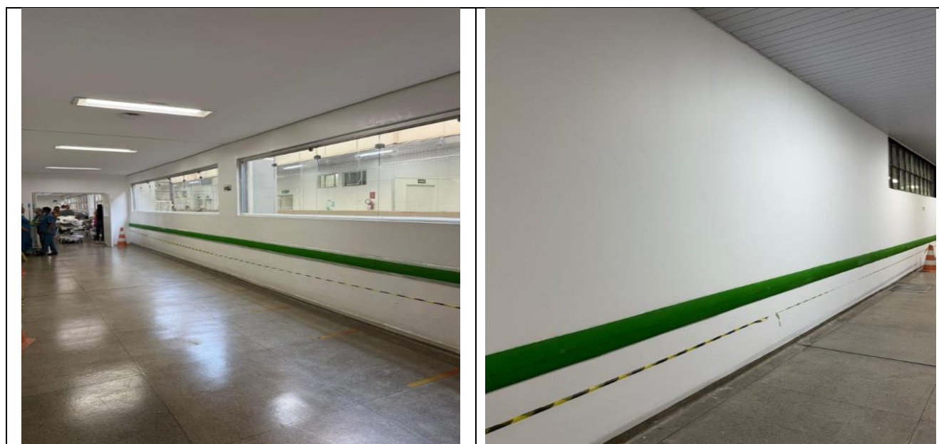
Figura 01 - Manutenção pintura subsolo e térreo
