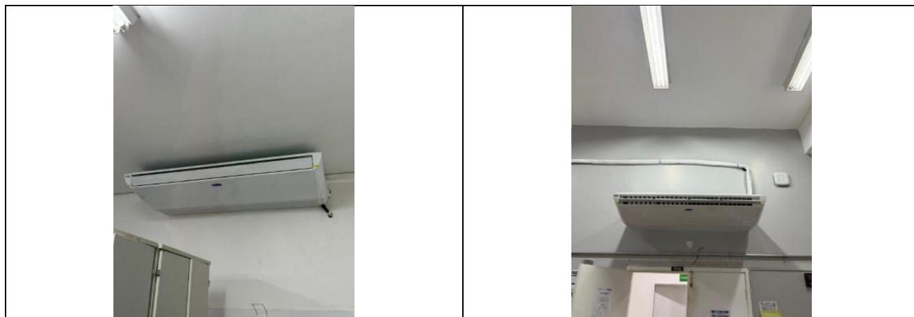
Figura 04 – Instalação de novos aparelhos de ar-condicionado
