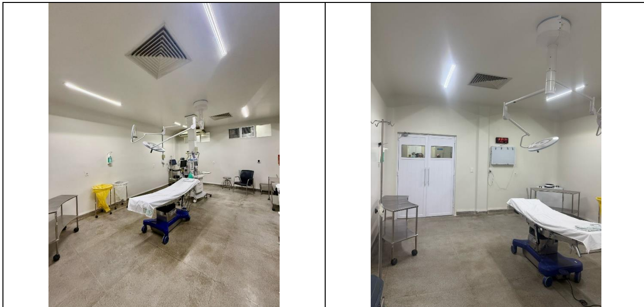
Figura 03 - Reforma das salas do Centro Cirúrgico
