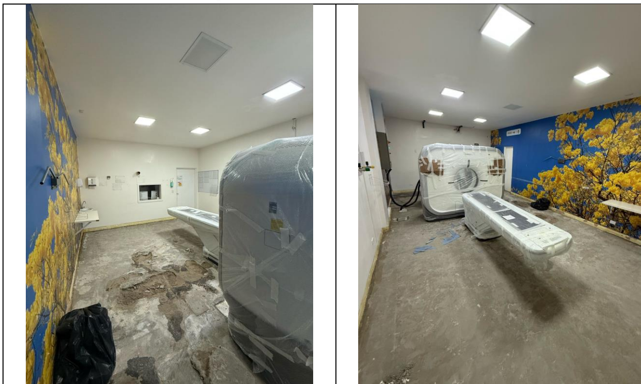
Figura 05 - Início da reforma piso da tomografia
