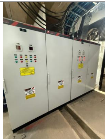
Figura 03 - Substituições dos painéis de baixa tensão na subestação.
