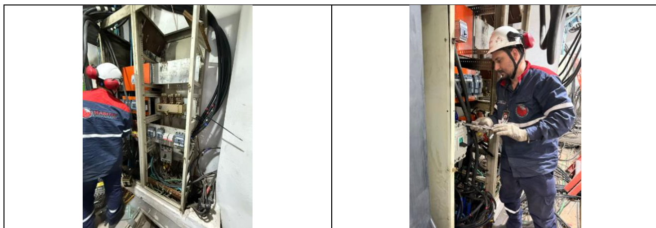
Figura 02 - Substituições dos painéis de baixa tensão na subestação.
