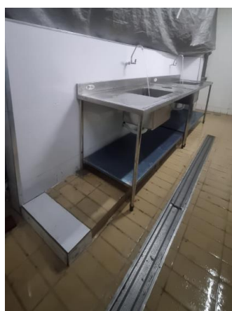
Foto 05 - instalação de novas bancadas na cozinha
