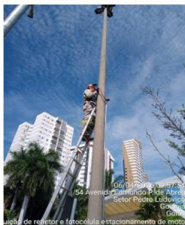
Foto 01 - Instalação de novos refletores
