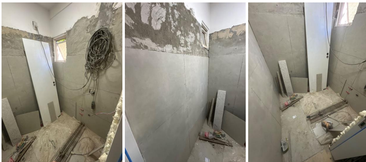
Figura 01. Obra reforma Banheiros
