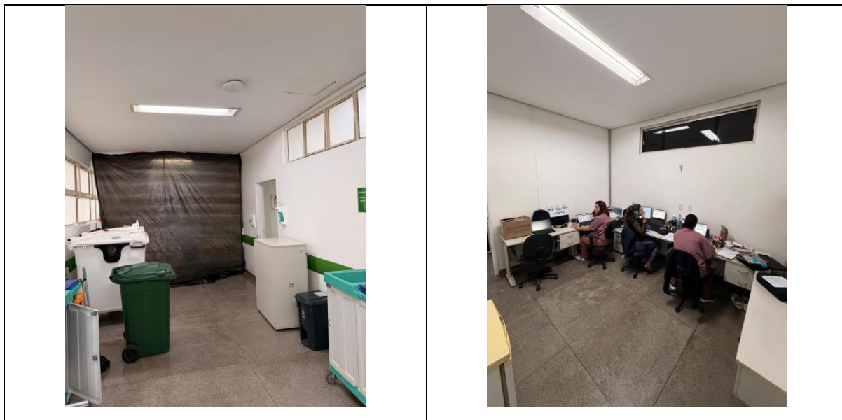
Figura 02 – Reforma da sala práticas e qualidade
