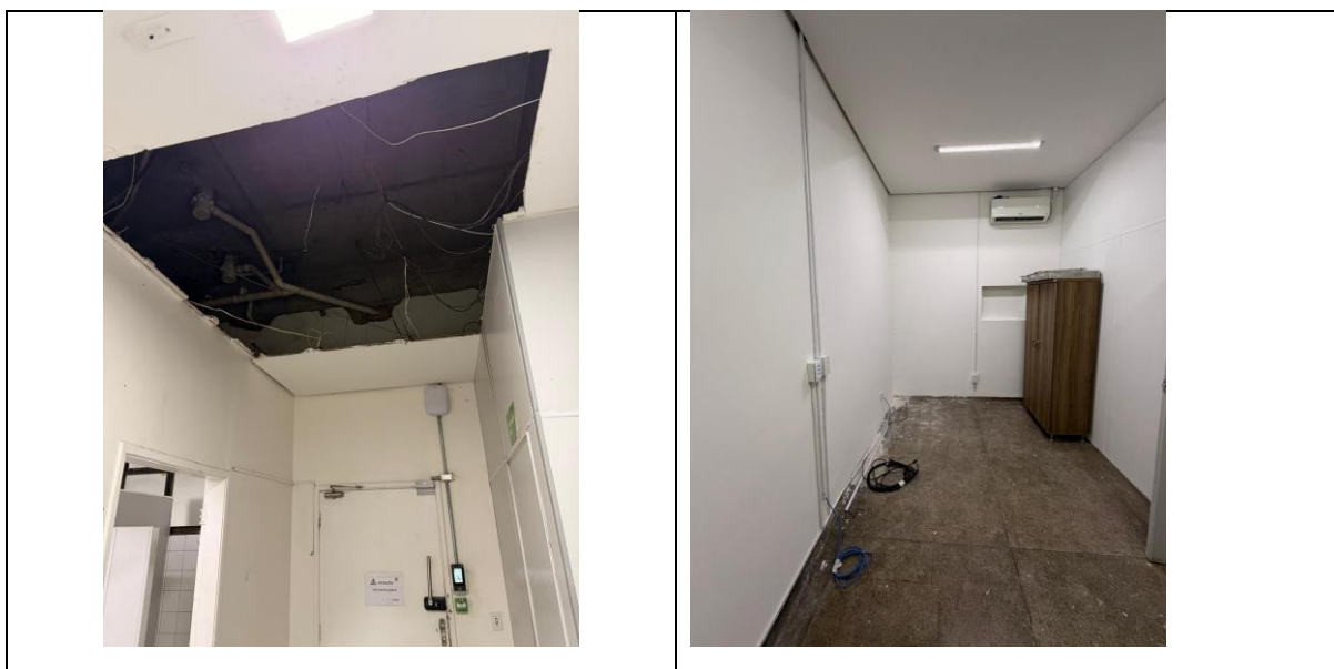
Figura 03 - Reforma da sala administrativo CME
