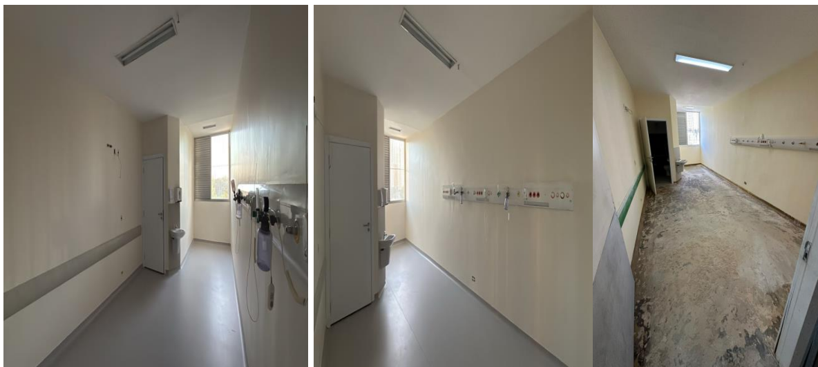
Figura 01. Obra Mantas 3º pavimento
