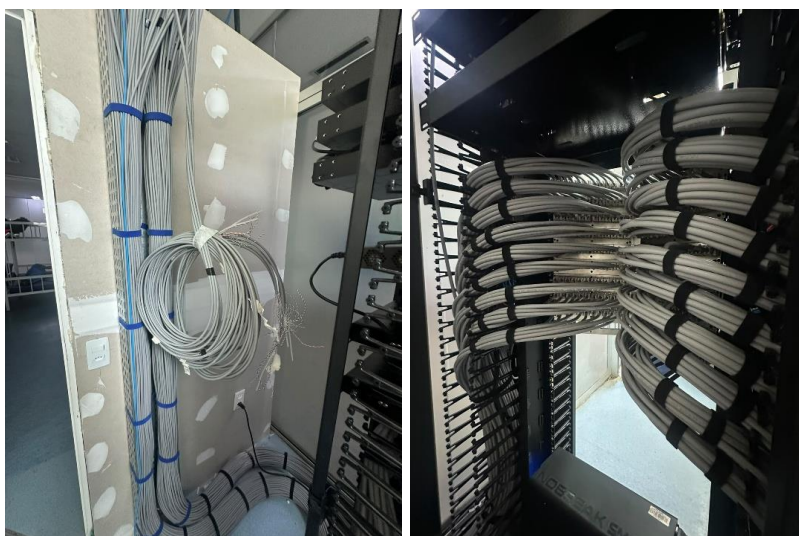
Figura 02. Obra Cabeamento Estruturado UTI 5
