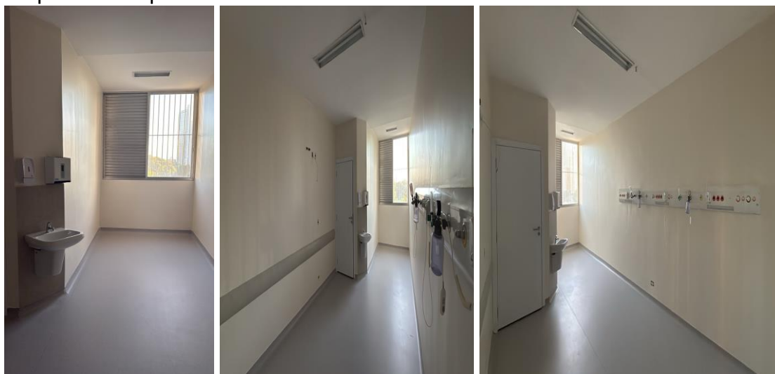
Figura 01. Obra Mantas 3º pavimento
