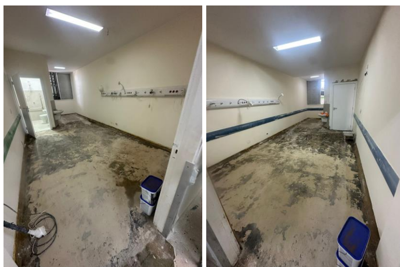
Figura 03. Obra Mantas 3º pavimento
