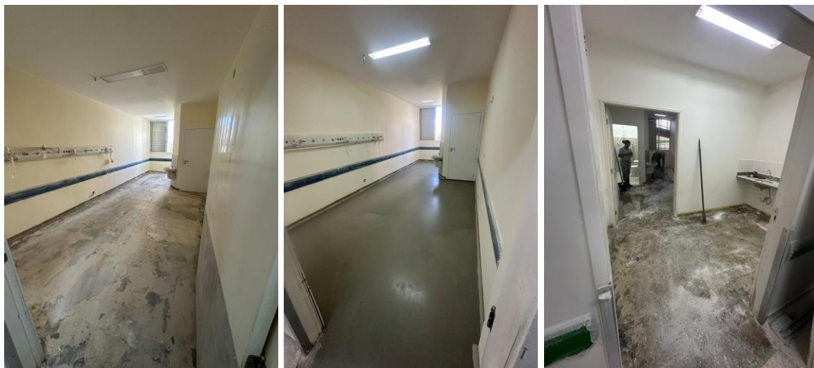
Figura 02. Obra Mantas 3º pavimento
