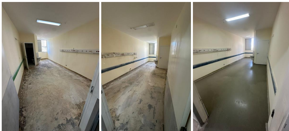
Figura 02. Obra Mantas 3º pavimento
