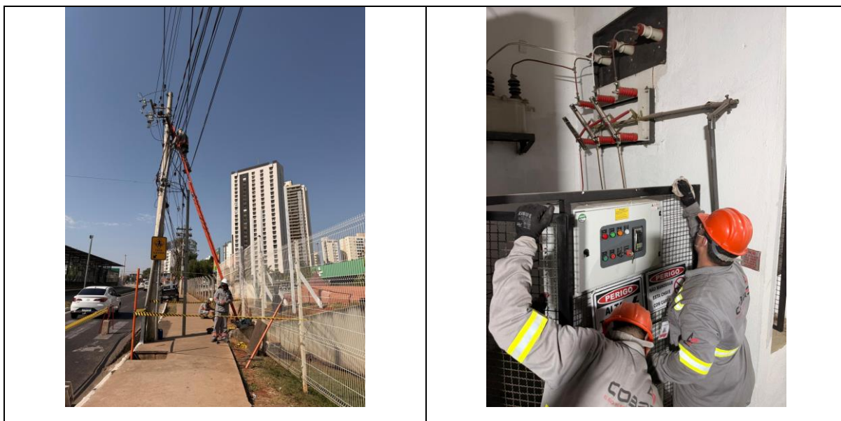
Figura 01 - Manutenção da Subestação
