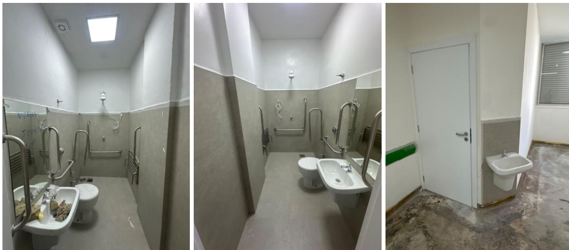
Figura 02. Obra reforma Banheiros
