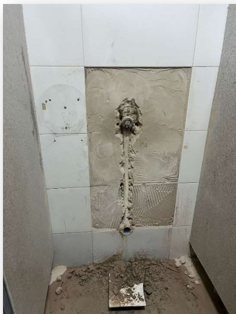
Figura 03 - adequação hidrosanitária banheiros - Antes e Depois
