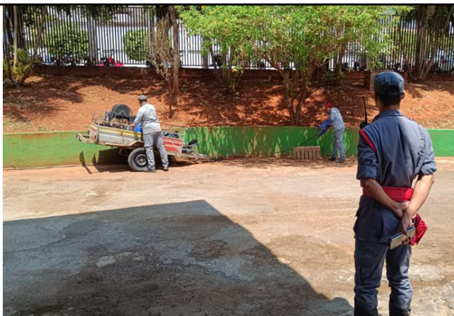
Figura 02 - Limpeza de caixas de águas pluviais
