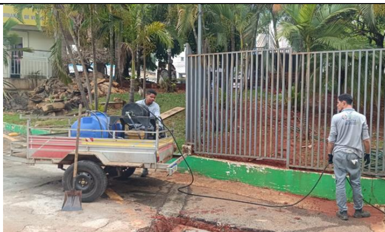
Figura 01 - Limpeza de caixas de águas pluviais
