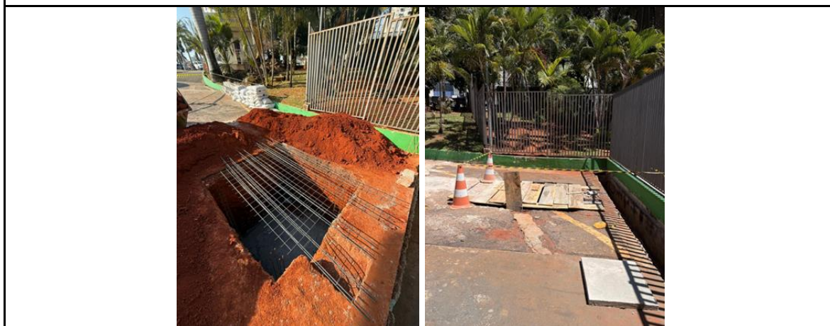
Figura 06 – Execução caixa de contenção
