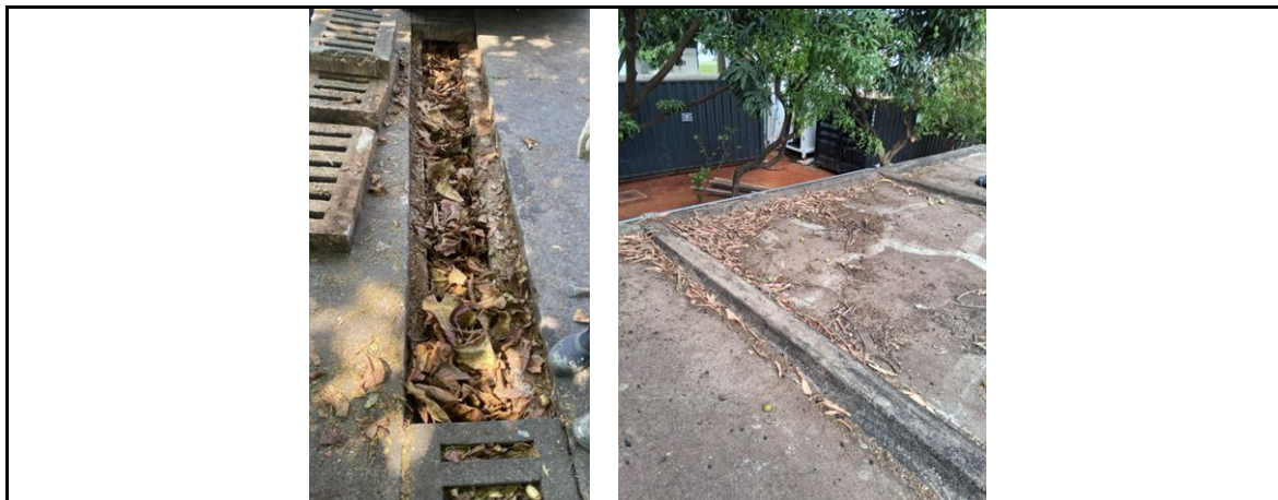
Figura 05 – Limpeza de valas e calhas
