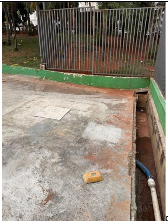
Figura 04 – Conclusão Bomba de Recalque
