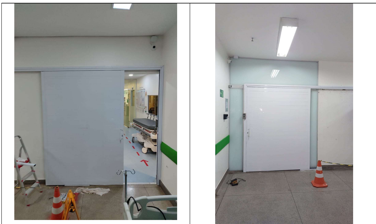
Figura 04 - Instalação de portas com controle de acesso nas UTI'S
