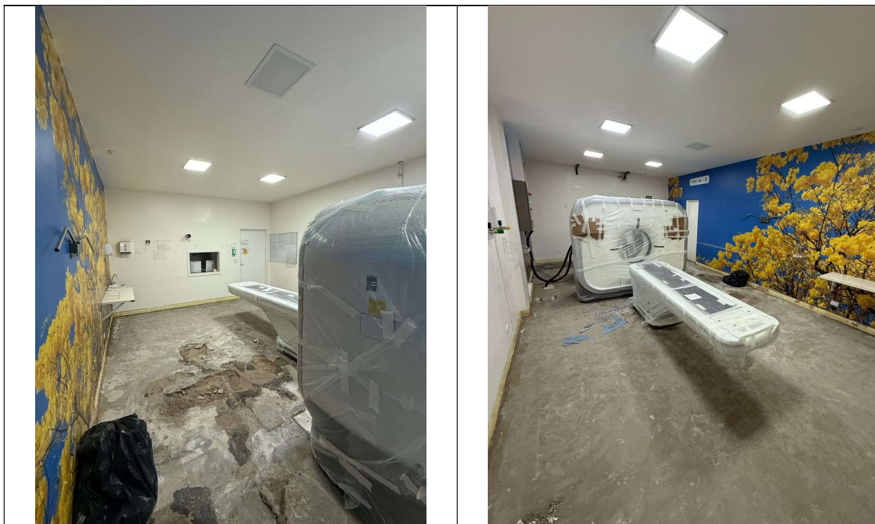
Figura 05 - Início da reforma piso da tomografia
